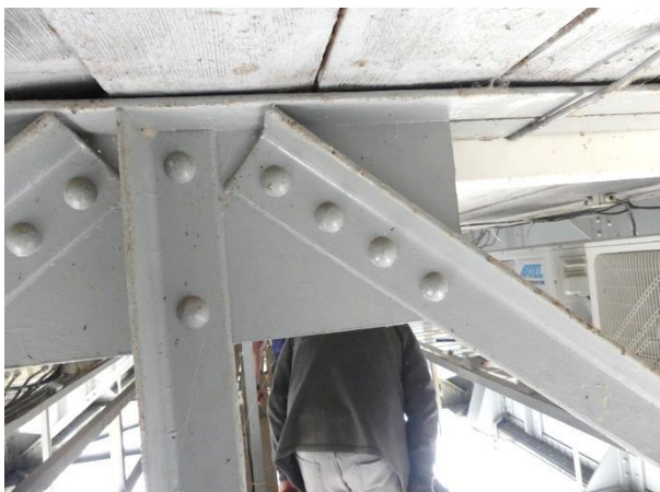
Obrázek 1b Ocelová konstrukce 1. patra – stav nátěrového systému
